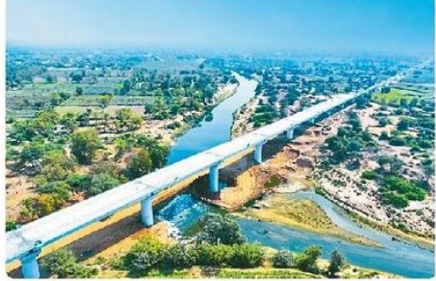
खेड़ा जिले की मोहर नदी पर पुल का निर्माण कार्य पूरा।
